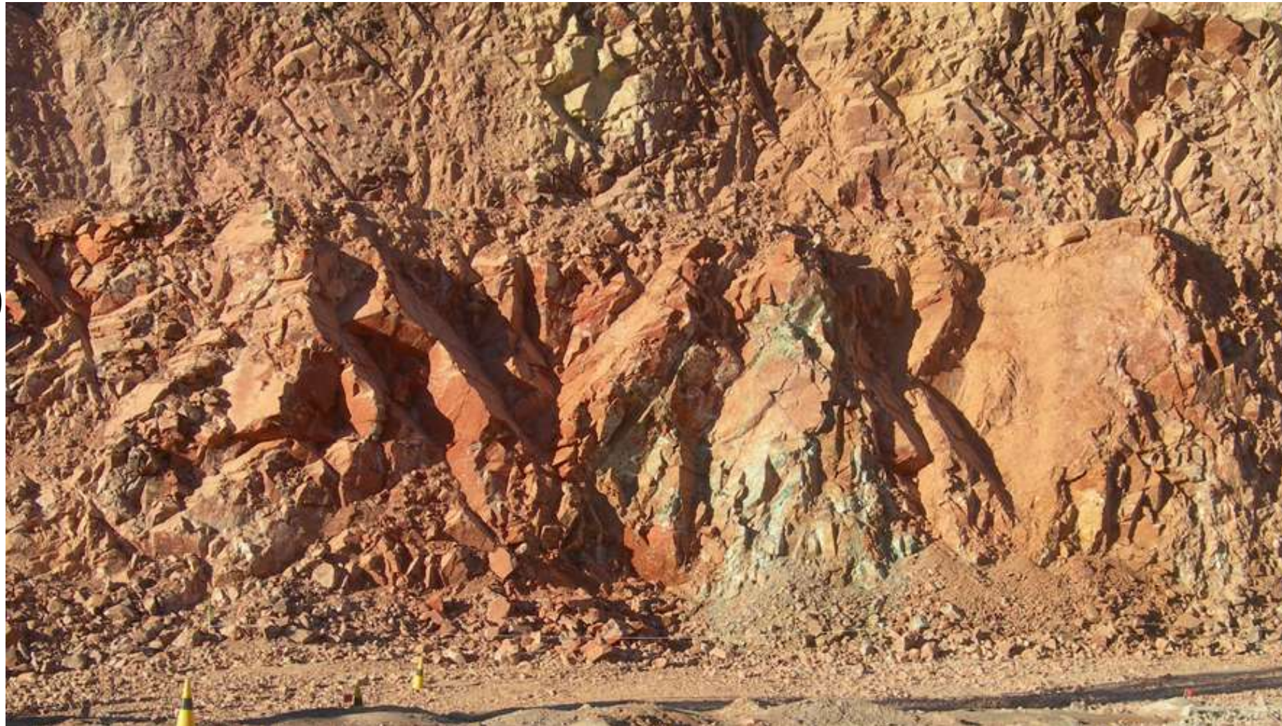
Falla por cuña formada por la intersección de dos discontinuidades
